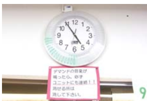
デマンドコントロールシステム
