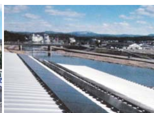
太陽光発電システム
