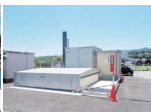
木質バイオマスボイラー
